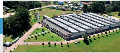
Vehicle Assembly Plant Caxias do Sul - RS - Brazil Unidad Ensambladora de Vehículos Caxias do Sul - RS - Brasil
